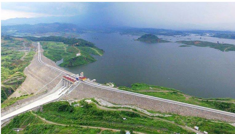
Jatigede Dam. http://sda.pu.go.id/pusben/
